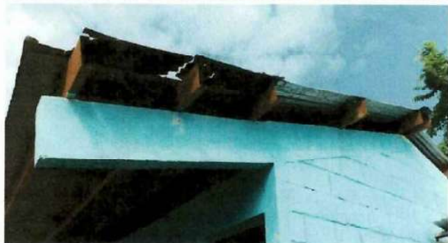
CAMBIO DEL CUBIERTO DE LAMINAS DEL EDIFICIO EDUCATIVO POR EL DETERIORO.
