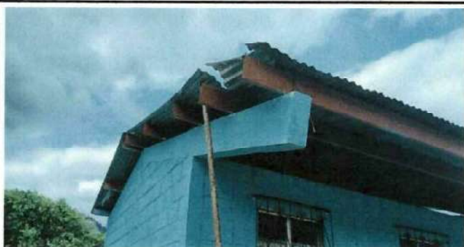
MANTENIMIENTO DE LA ESTRUCTURA DEL TECHO
