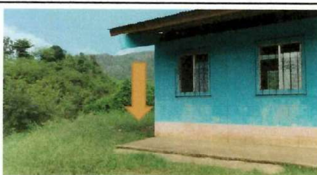
ESPACIO DONDE SE REALIZARA LA MANO DE OBRA ESPECIALIZADA (ALBAÑILERIA, HERRERIA, ELECTRICIDAD Y PLOMERIA)
